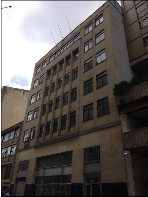
Ilustración 4. Fachada general de la sede principal
