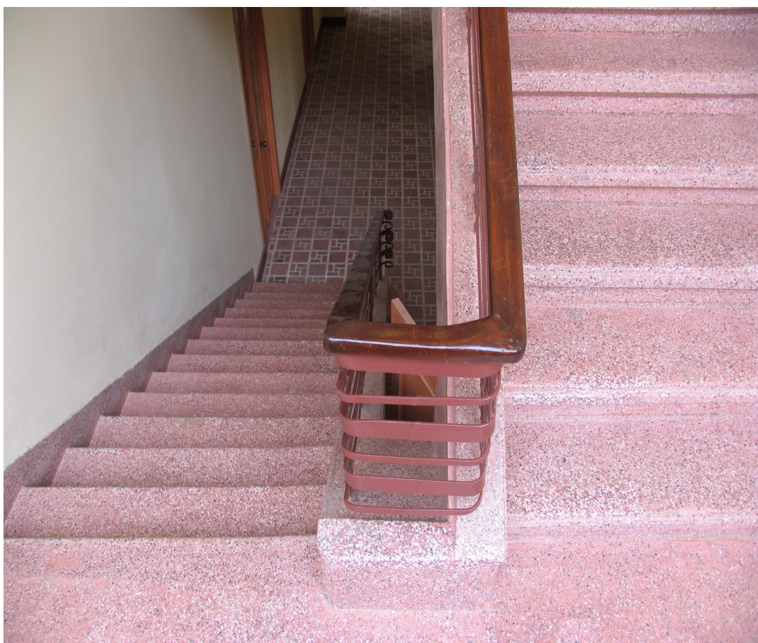
Escalera Interna de la Casona de la Danza
